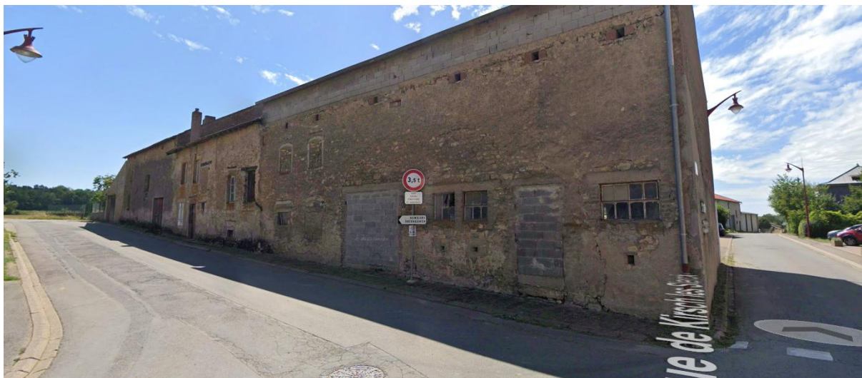
Bâtiment destiné à être démolit
